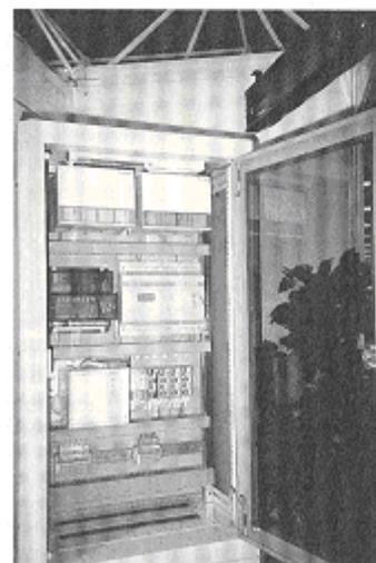
KGM-Stand mit einer Leitebene, auf die die Fabrikate L&G, SAIA, Honeywell und Andover Controls aufgeschaltet sind. (Alle Abb. Höschele)
